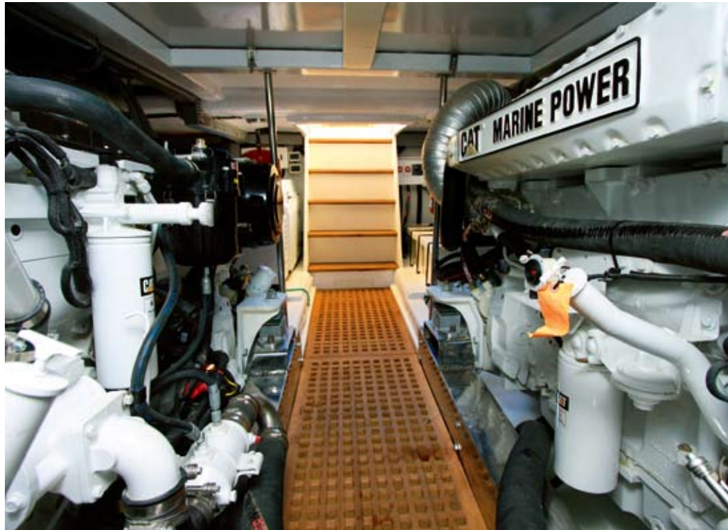
■ Najveći od triju prostora pod krmenom palubom pripada strojarnici, u kojoj su dva snažna dizelska motora Caterpillar C 12 Acert, snage po 705 KS, te elektrogenerator i sustav za grijanje i hlađenje
